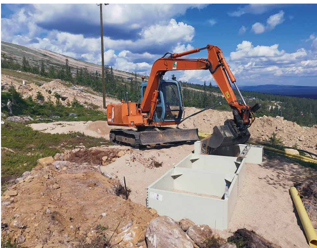
Muuntamon pohjan tekoa Saaganrinteellä, Ylläksellä.
