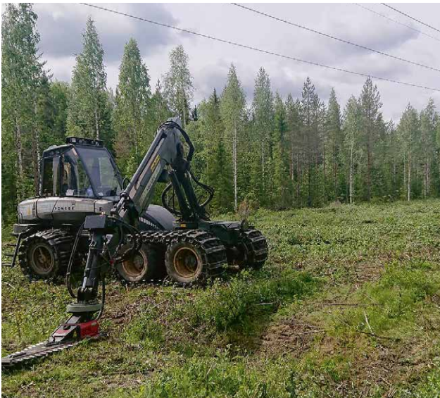
Keminmaa – Liakka 110 kV linjalla raivauksen jälkeen.
