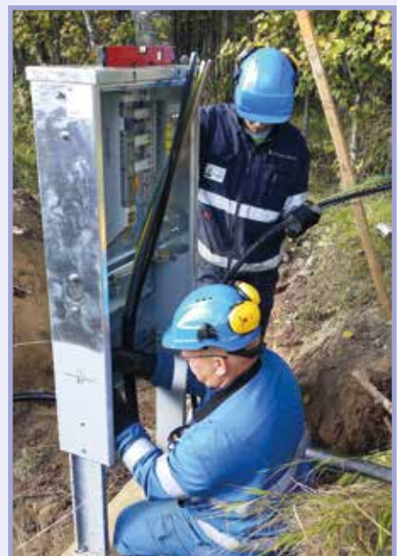
Katujakokaapin kytkentä Torniossa.
